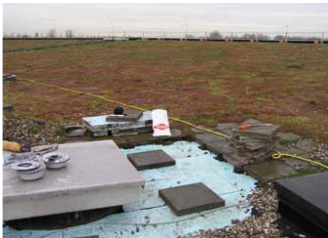
Onderzoek extensief begroeid dak met tegels op tegeldragres
